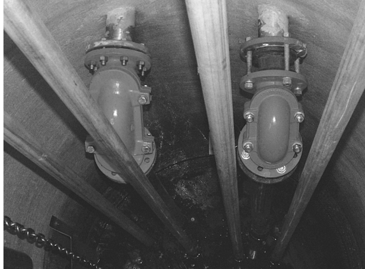
Rys 1. Zawory systemu SZUSTER: Po lewej - zawór o długiej zabudowie (poprzednia konstrukcja); po prawej - nowy zawór o krótkiej zabudowie
